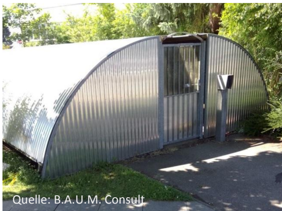
Quelle: B.A.U.M. Consult Abbildung 14: Überdachte und abschließbare Fahrradabstellanlage bei Firma Kern-Liebers in Schramberg
